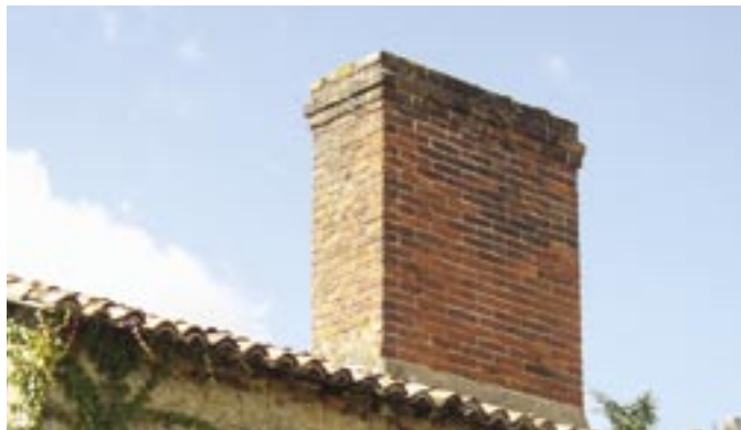
Deux exemples de cheminées maulévraines.
