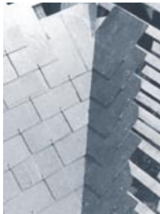
Noue fermée en zinc.
