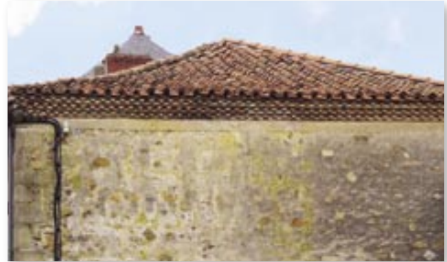
Toiture à croupes couverte en tuiles canal.
