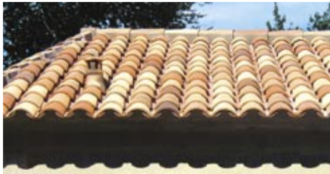
Toiture en tuiles canal.
